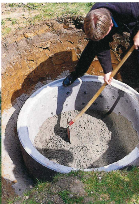
Schachtversickerung im Bau
