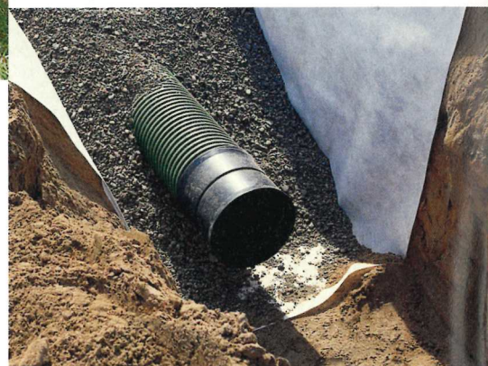
Rohr-Rigolenversickerung im Bau
