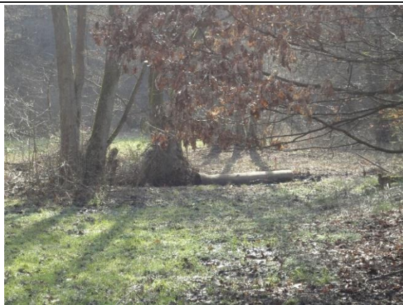
Foto 15. Bachverrohrung Flurstück 21, Flur 22
