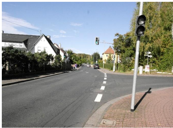
Foto 4: Anschlusspunkt Ahornstraße an die Idsteiner Straße
