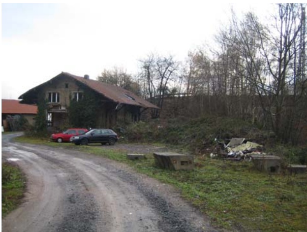
Blick in Richtung Bahnbrücke
