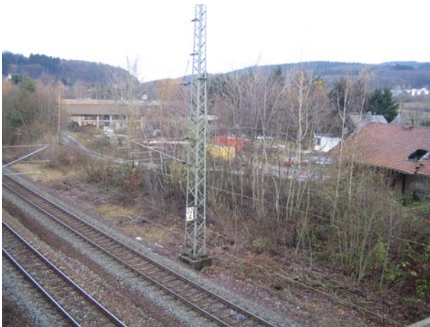
Plangebiet, Blick von der Bahnbrücke
