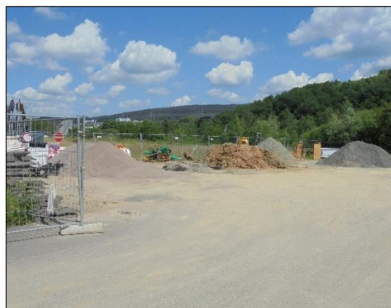
Lagerflächen im Plangebiet
