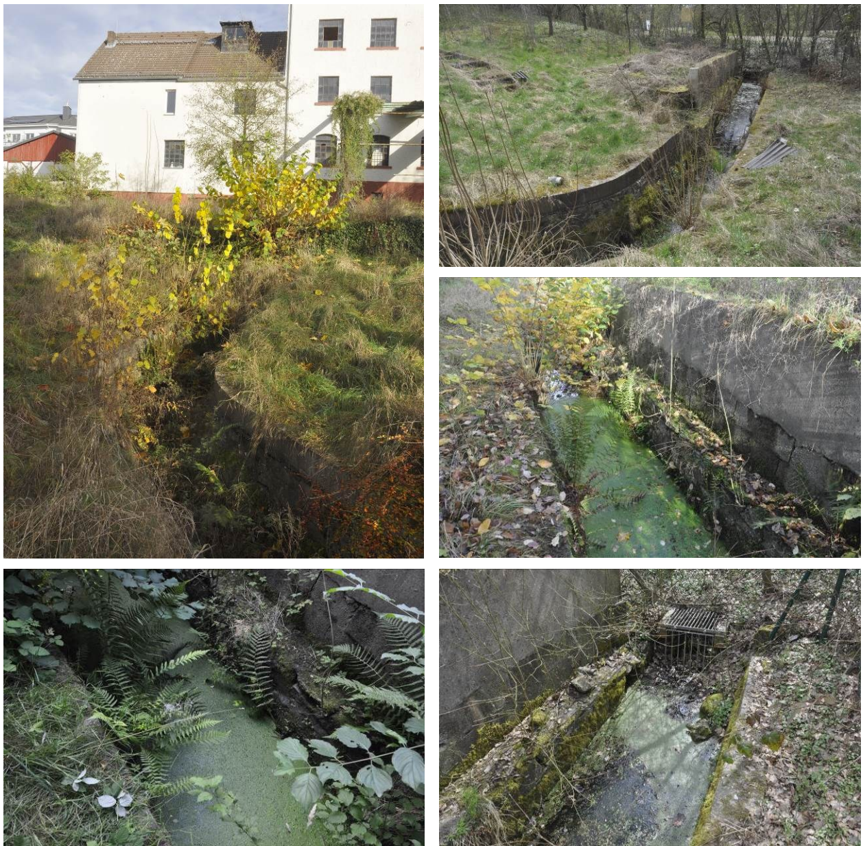
Abbildung 14: Mühlengraben mit Wasserlinsendecke ohne Befund eines Amphibienbesatzes in 2021
