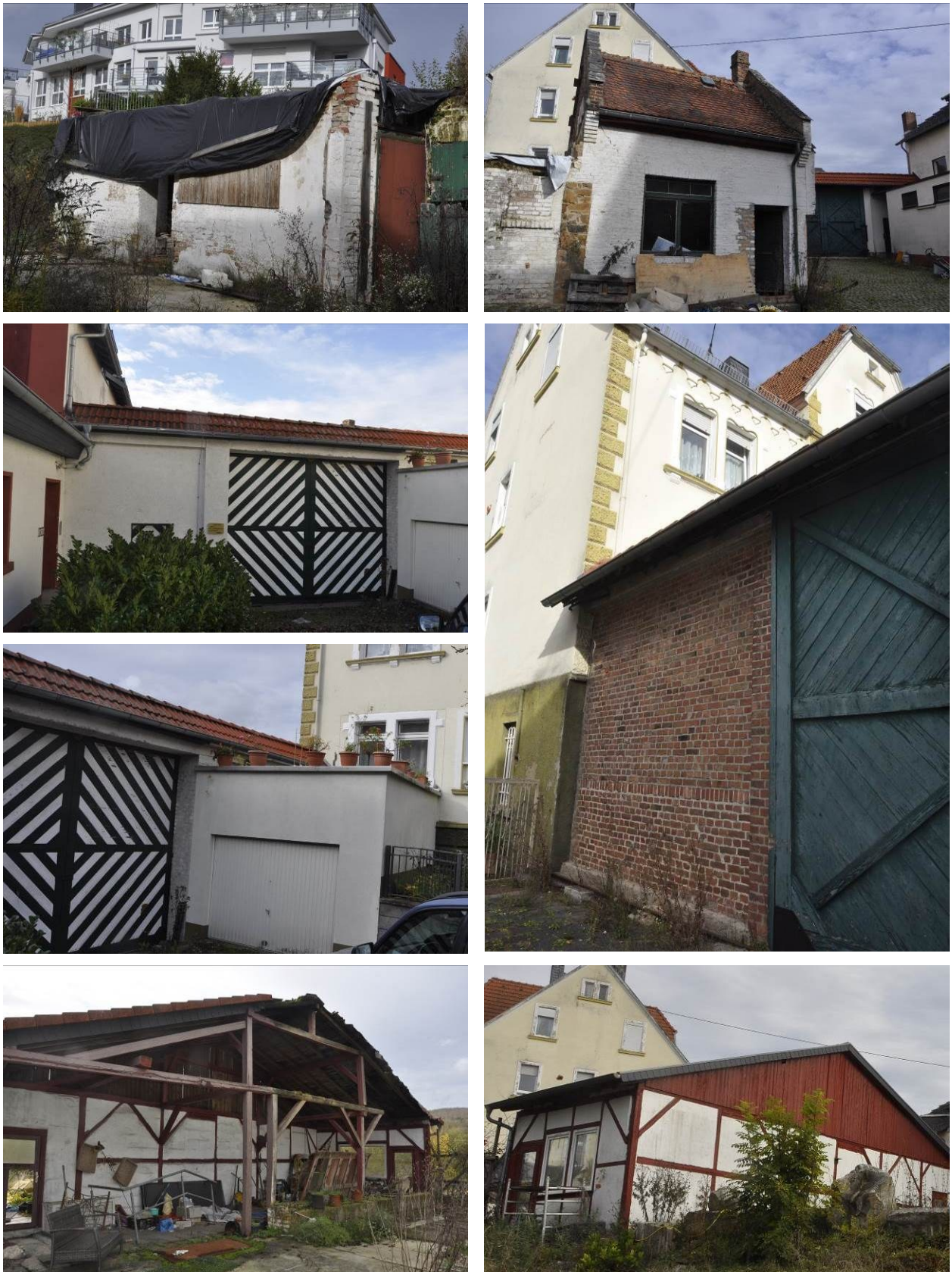
Abbildung 6: Stallung (oben), Toreinfahrt (Mitte) und Schuppen (unten)
